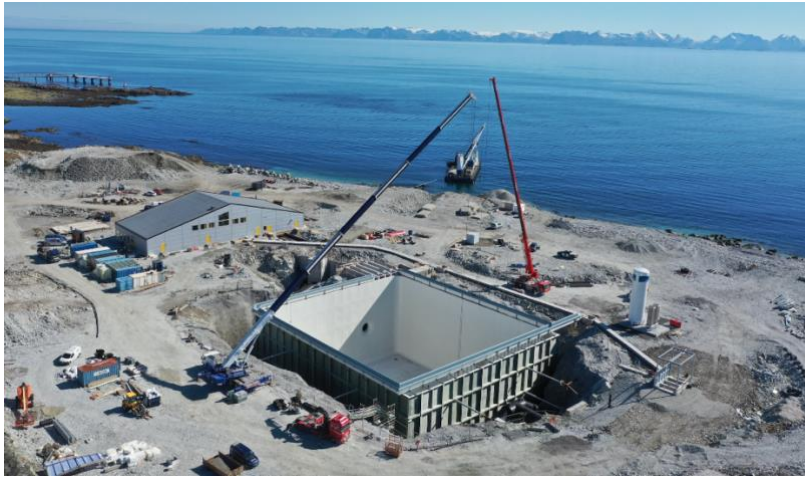
Figur 5 Andfjords anlegg i byggefasen
