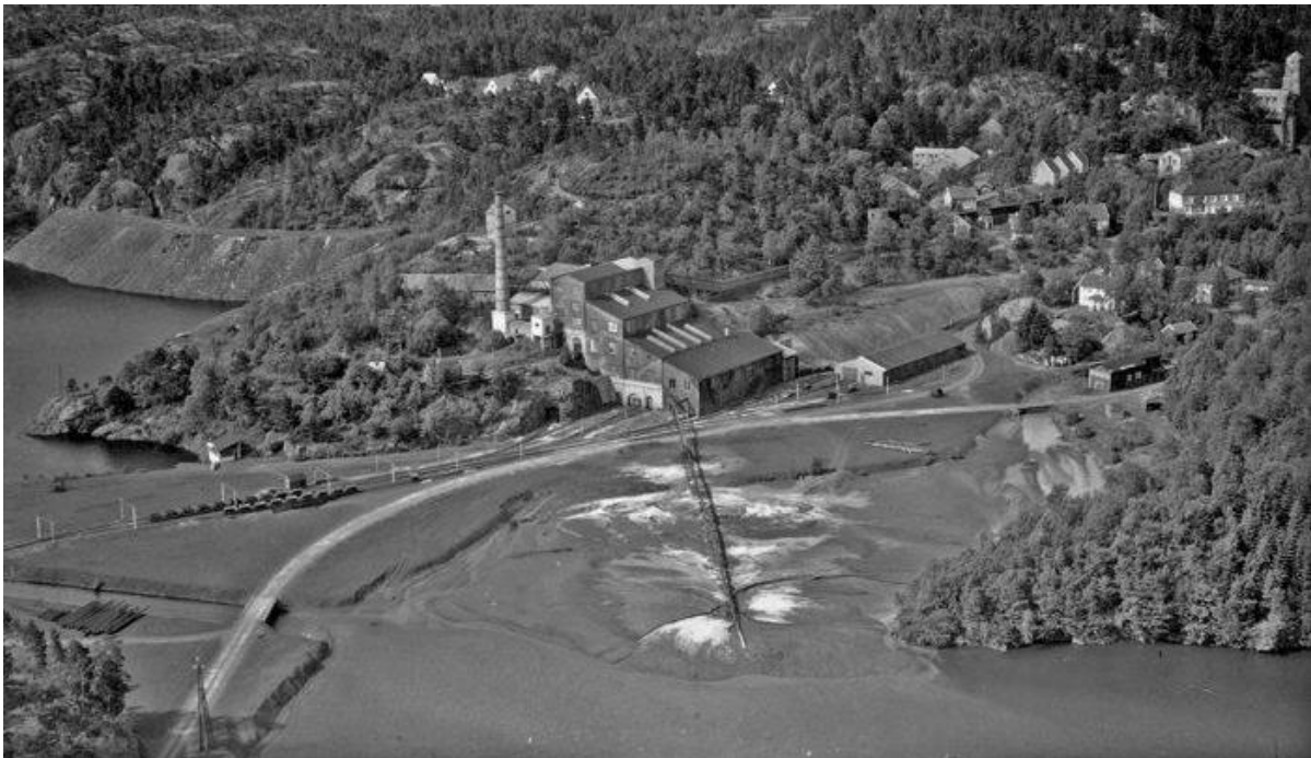
Fig 2.2. Fotografiet viser vaskeriet (oppredningsverket) på Litlabø og deponeringen av avgangsmasser ut i Storavatnet og Hustredalsvatnet helt til venstre i bildet. Fotografiet er tatt på 1950-tallet. (Hentet fra: Tautra (u.å))
