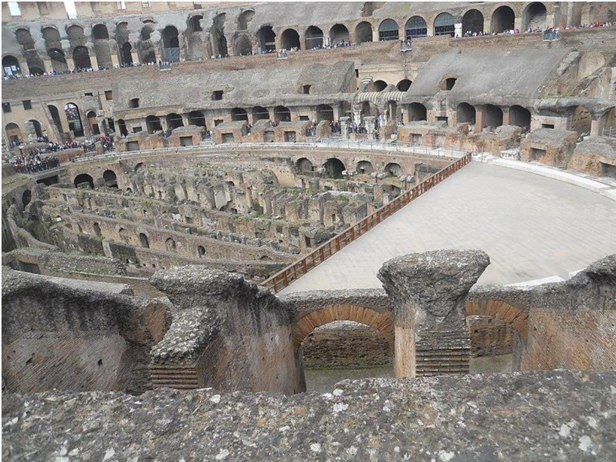
Figur 20: Arena i Colosseum, med rekonstruert gulv. Under ser vi Colosseums hypogeum, hentet fra: https://commons.wikimedia.org/wiki/File:Colosseum_Arena_(5986632567).jpg
