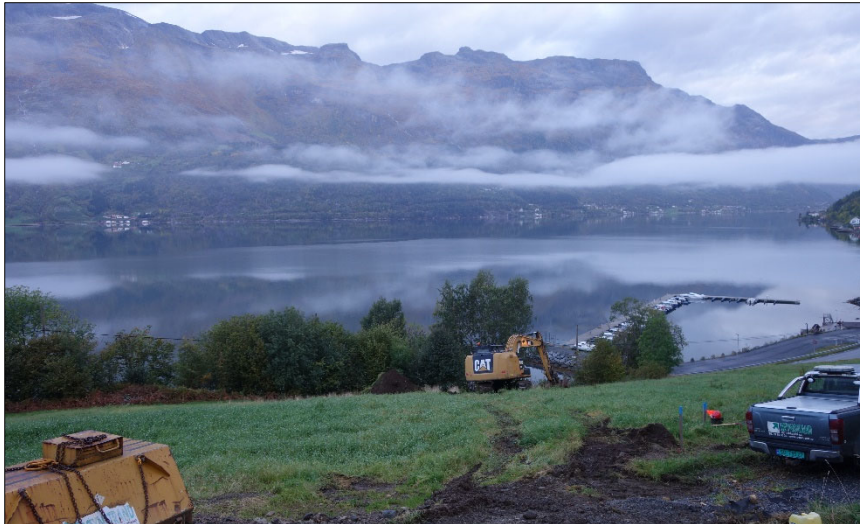
Figur 4. Oversiktsfoto før graving. De blå stikkene markerer enden på eksisterende OV-ledning. Sett mot nordvest.
