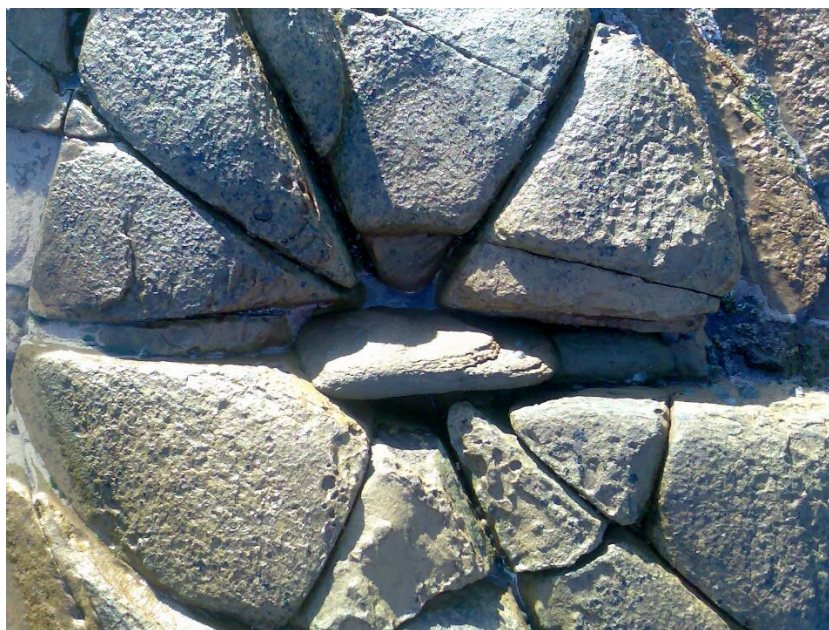
BILDE 1: ET EKSEMPEL DER MAN TYDELIG KAN SE SPREKKER OG DISKONTINUITETER I EN STEIN.
