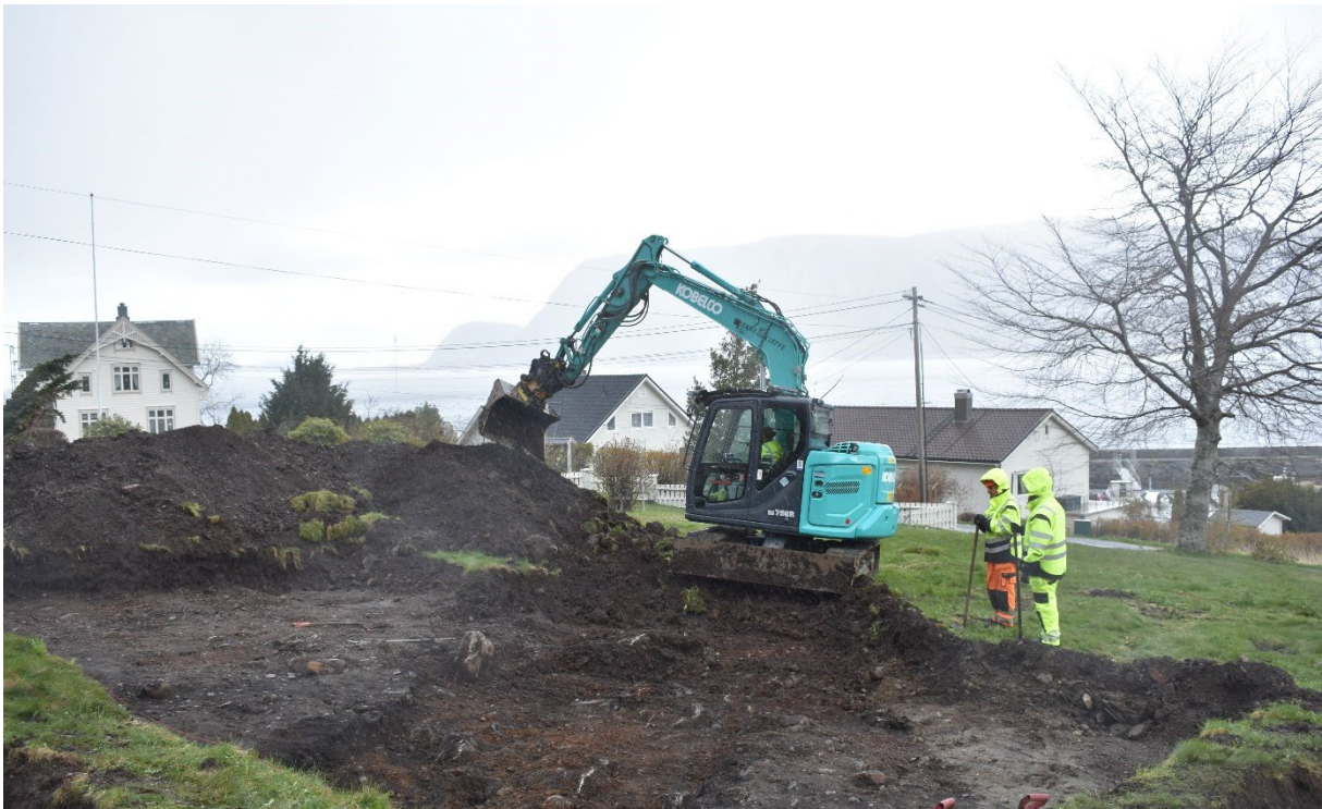
Figur 9 Maskinell avtorving sett mot nordøst.
