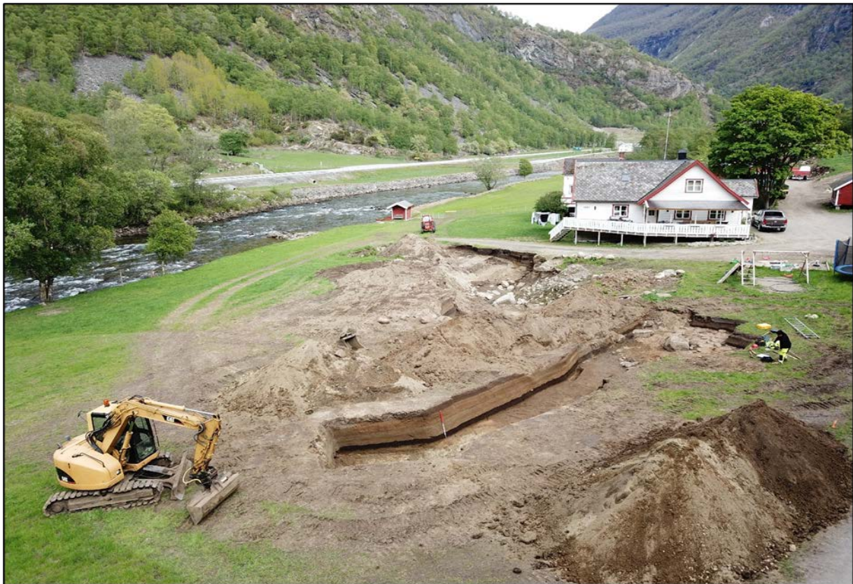
Figur 11 Tunet og id 248364, sjakten synlig i forkant.
