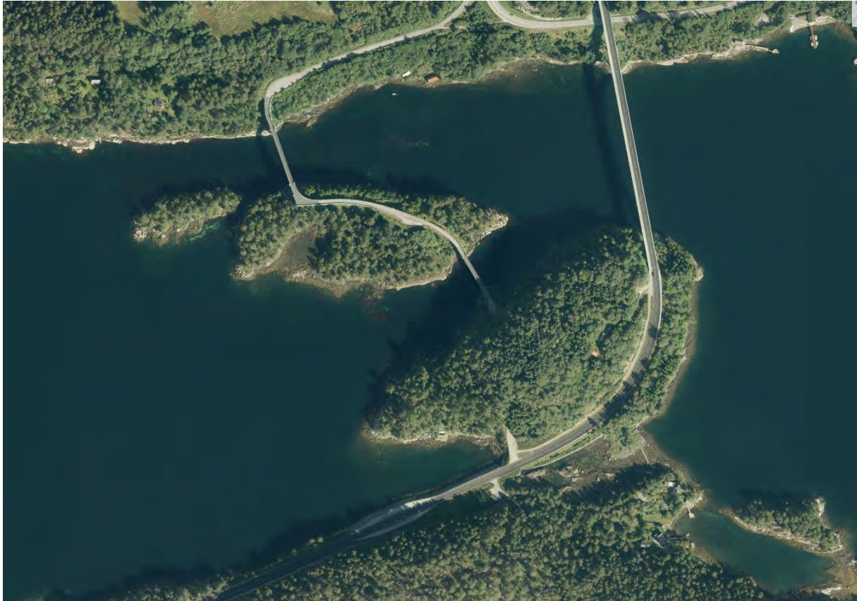
Figur 10 Flyfoto av Skodje etter bygging av RV 661.
