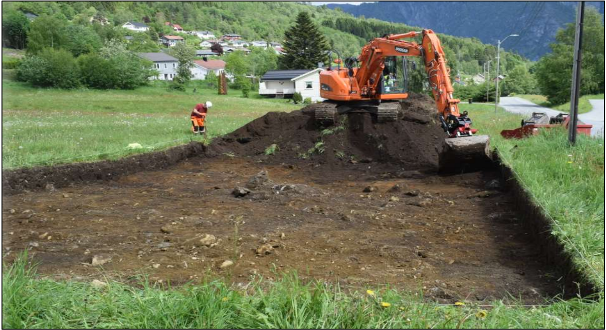
Figur 11. Arbeidsbilde, flateavdekking med gravemaskin.
