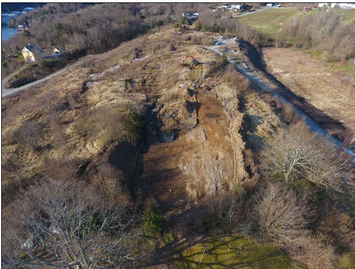
Figur 7. Dronefoto av Lok 1 etter avtorving. Gravemaskin synlig i bakgrunnen har begynt arbeidet ved Lok 2. Sett mot sørvest. Foto ved Universitetsmuseet i Bergen.
