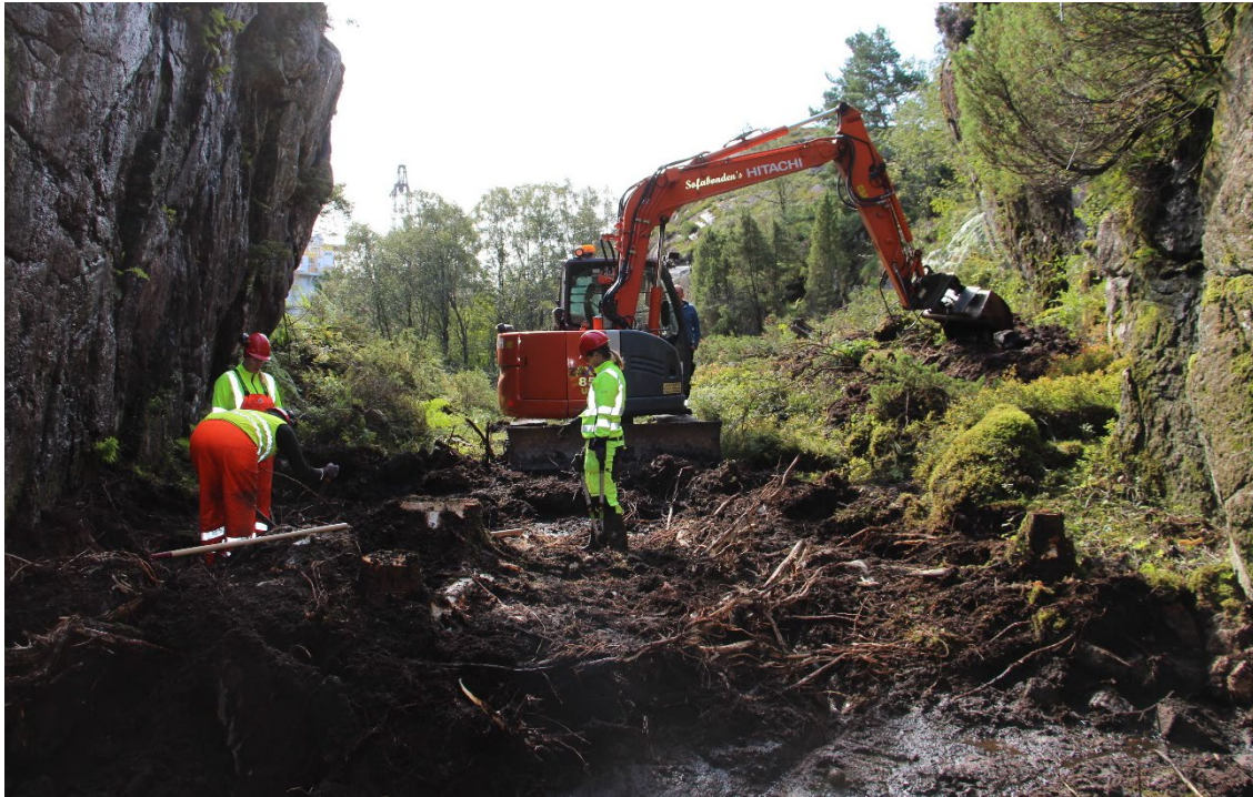
Figur7. Arbeidsfoto, avdekking med gravemaskin, sett mot sør.
