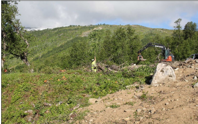
Figur 5. Manuell og maskinell rydding av vegetasjon på flaten. Ser fyllingen til grusveien til høyre i bildet, sett mot vest.
