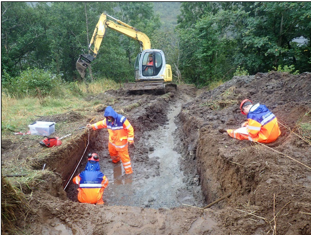
Figur 57 Arbeidsfoto lokalitet 6, vannføring- og erosjonsproblematikk tydelig!
