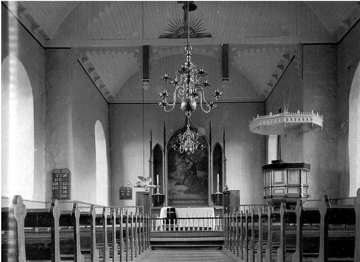
Fig 4.17. Kirken etter ombyggingen i 1870-71 sett fra innsiden fra skipet i vest mot koret i øst. Som vi kan se, er korbuen borte og murene er kalkpusset og lyse. Fra vinduene flommer det lys inn (Kilde: Lidén 2003: 23)
