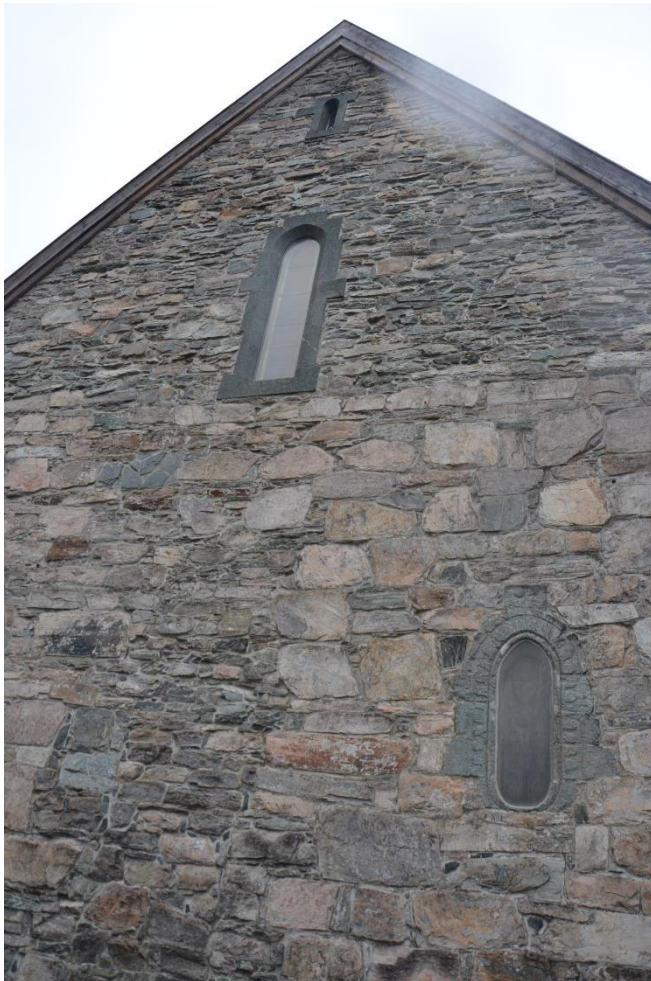
Fig 4.15. Korets østgavl sett utenfra. Her ser vi variasjoner i murverket. (Foto: Marius Fugelsnes 16.02.2015)
