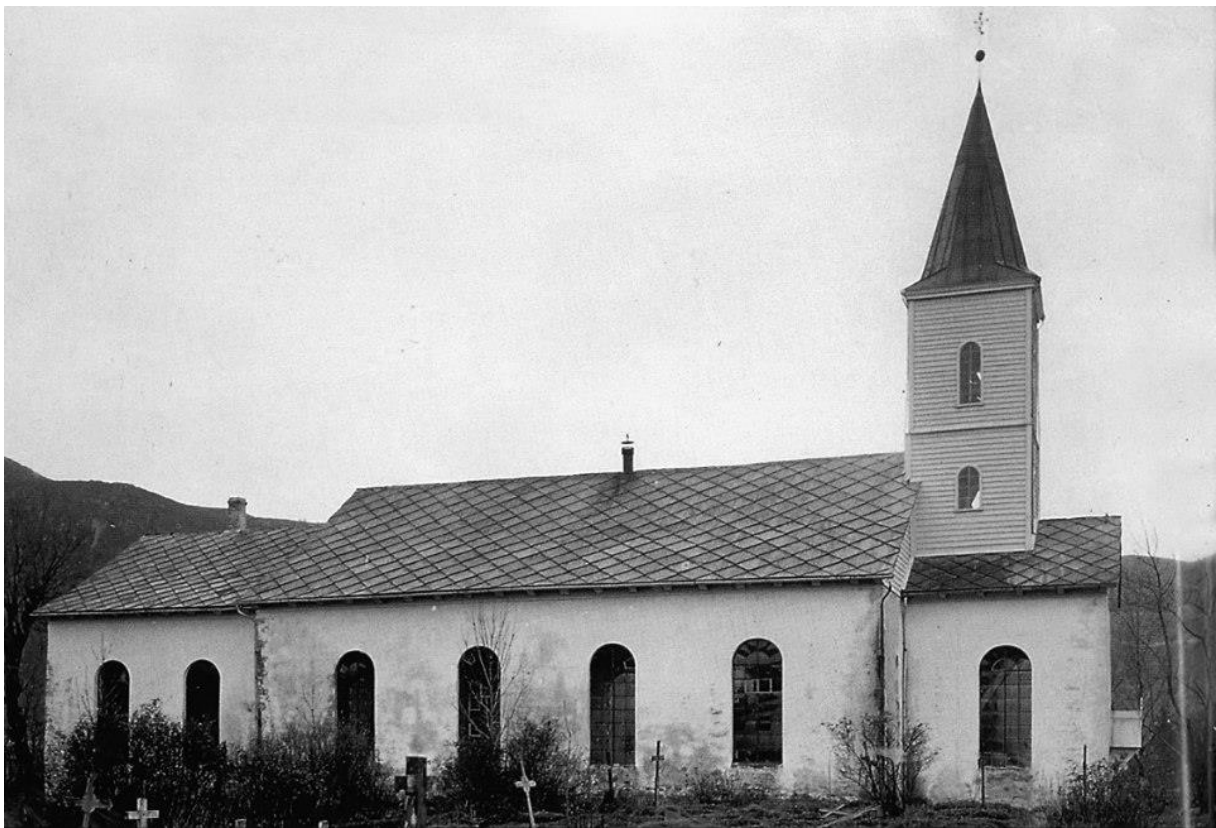
Fig 4.16. Bildet er fra kirkens utside fra ombyggingen i 1870-71 sett fra nord mot sør. Det er altså nordmuren vi ser på bildet. Her kan vi se at kirken er kalkpusset og har mye større vinduer enn i dag, både i skipet og i koret. Takets vinkler er også annerledes, og tårnet er noe spinklere enn det som står i dag. (Kilde: Lidén 2003: 22)
