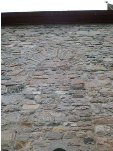
Fig 4.6. På veggen er det muret en bue, lik som de andre vindusportalene i skipet. Den bærer romansk preg som resten av vinduene i skipet, derav rundbuen med vertikale steiner på den ellers horisontale muren. (Foto: Marius Fugelsnes 13.02.2015)
