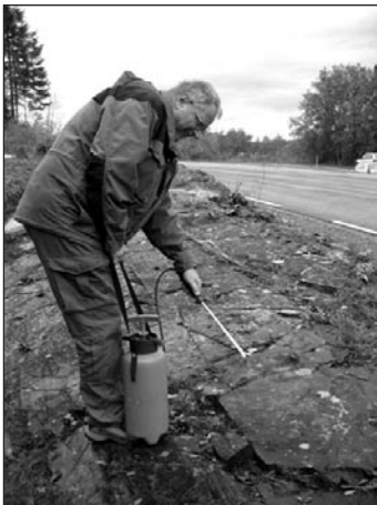
Figur 3. Roar Sæterhaug spriter før tildekking på Holtås, Nord-Trøndelag. Foto: C. Olsson, Stjørdal Museum.
