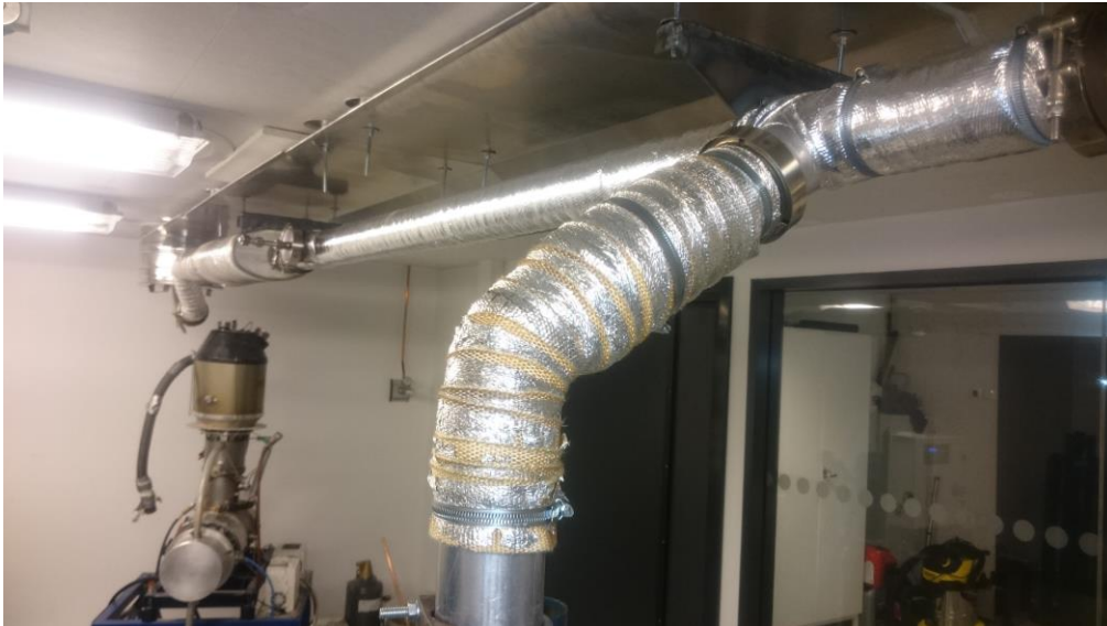
Bilde 56: Eksosystem motorlaboratorium
