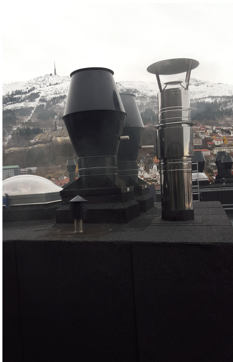
FIGUR 3.1: Avkasthette på tak med regnskjerm, avkasthetter i svart ved siden av.
