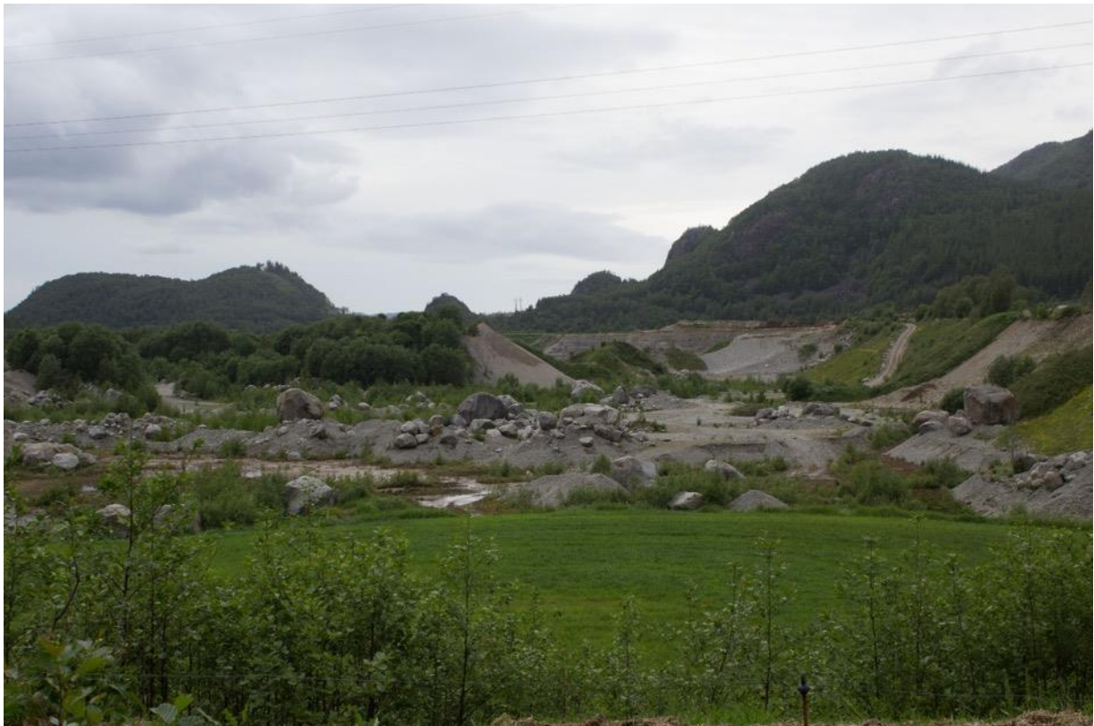
Figur 3.5 Bildet øst i grustaket retning vestover. Konsentrasjonen av blokker på bunnen av grustaket er størst helt øst i grustaket og ser ut til å avta vestover.
