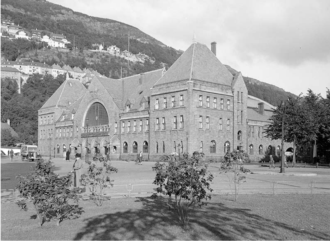
FIG. 59. Jernbanestasjonen, tegnet av Kielland, med sine fasader i råkopp. Foto: Atelier K. Knudsen, ukjent år. Hentet fra: KK-postkortsamlingen, Universitetsbibliotekets bildesamling.
