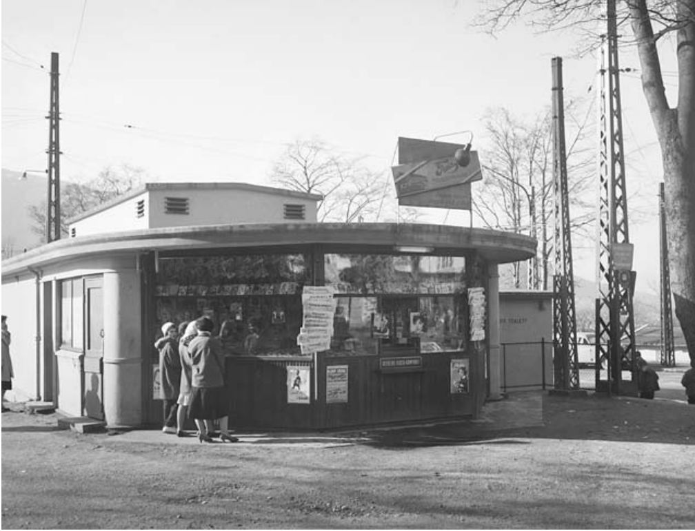
FIG 53. Ventepaviljongen i Fridalen. Kioskbyggingen etter fullførelse. Freia reklamerer fortsatt på taket. Foto: Atelier KK, 1959. Hentet fra: Nyere KK-samling, Universitetsbibliotekets bildesamling.
