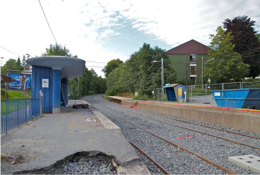
FIG. 69. Slemdal, venteskur fra 30-tallet, av arkitekt Kristoffer Lange: «smekre betongtak, kun understøttet av et par elegante søyler», (Hartmann og Mangset, 2001, s. 32). Tilgjengelig fra: https://da.wikipedia.org/wiki/Slemdal_Station [hentet 01.04.2017]
