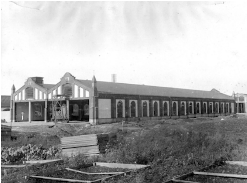
FIG. 64. Vognhall på Majorstuen. En slags dobbel Møhlenpris-løsning. Foto: Løkke foto, ukjent år. Eier: Oslo Byarkiv. Tilgjengelig fra: < http://oslobilder.no/BAR/A-40205/Ua/0002/021 > [hentet 21.03.2017]
