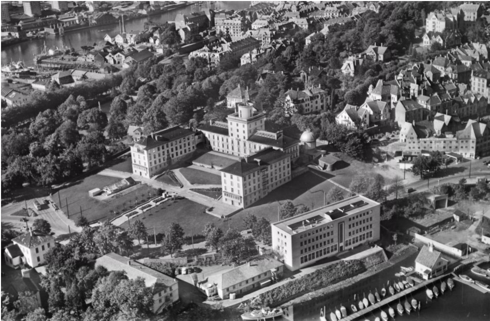
FIG. 44. Geofysisk institutt av arkitekt Egill Reimers. Rotunden synlig på toppen av bygningens sentralfløy. I bildets nedre billedkant til høyre kan vi se strandlinjen mot Store Lungegårdsvann, et område som i dag er dekket av et stort veisystem. Foto: Widerøe's Flyveselskap, 1958. Hentet fra: Widerøe-samlingen, Universitetsbibliotekets bildesamling.
