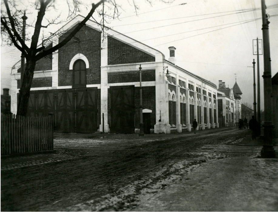
FIG. 61. Hospitalsløkkan vognhall av arkitekt Alf Hofflund. Rundbuestilen gjør seg gjeldende også her.
