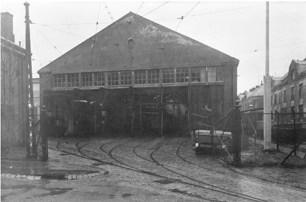
FIG. 6. Trikkehallen på Møhlenpris, fotografi fra 1938. Vinduene over portene er sammen med portene og vinduet midt i gavlfeltet typiske innslag for vognhaller. Foto: Atelier KK. Hentet fra: Nyere KK-Samling, Universitetsbibliotekets bildesamling.
