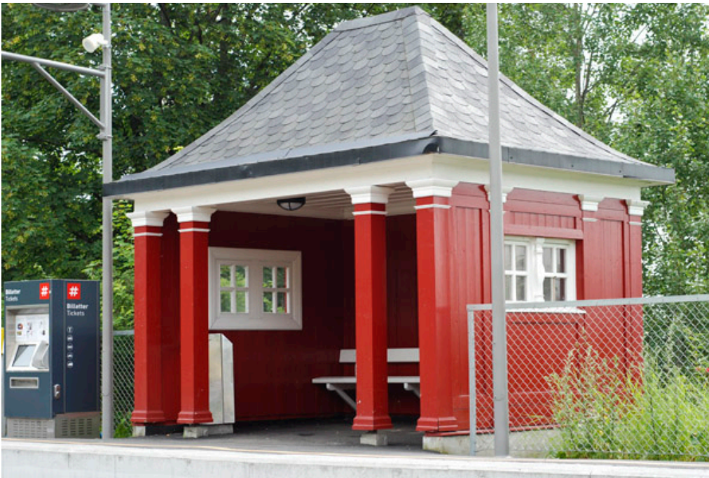
FIG 68. Gråkammen venteskur av arkitekt Erik Glosimodt, som tegnet mange av bygningene langs Holmenkollbanen. Blant annet disse nybarokke venteskurene. Foto: Mogens Juul Rasmussen, 2011. Tilgjengelig fra: < http://kletvold.no/glosimodt/wp-content/uploads/2011/04/venteskur.jpg > [hentet 01.04.2017]
