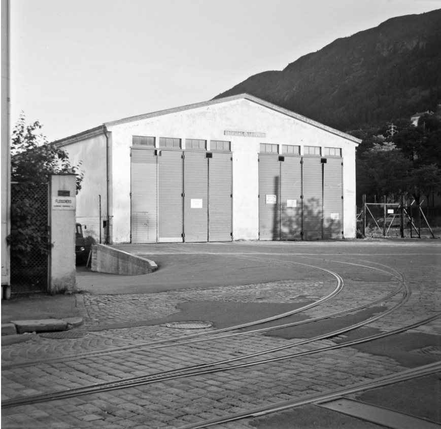
FIG. 15. Solheim Vognhall, med trikkeskiner i forgrunnen. Høye garasjeporter til innkjøring av vogner.
