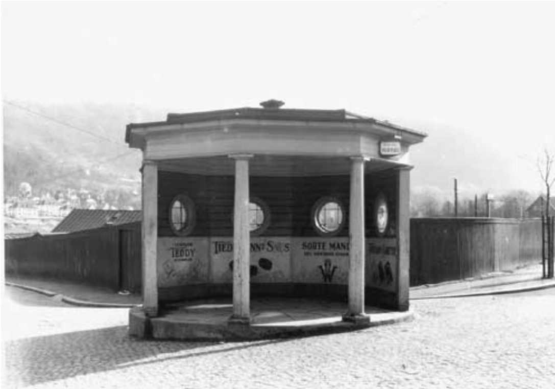
FIG. 24. Venteskur i krysset Bjørnsons gate–Inndalsveien, som realisert. Tobakksreklame innvendig. Foto: Atelier KK, 1927. Hentet fra: Nyere KK-samling, Universitetsbibliotekets bildesamling.
