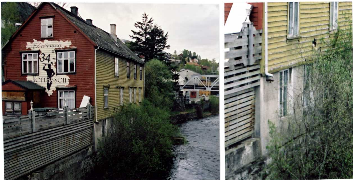
Fig. 1.7 Ein kan sjå fargeskilnad i muren på Madsenhuset, som syner kor høgt vatnet sto under flaumen i 1918. Det nådde midt opp på dei nederste vindauga.
