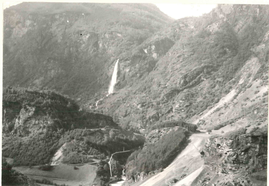
Fig. 38 Terrasser i M.G. ved Furu- berget (mot SW).
