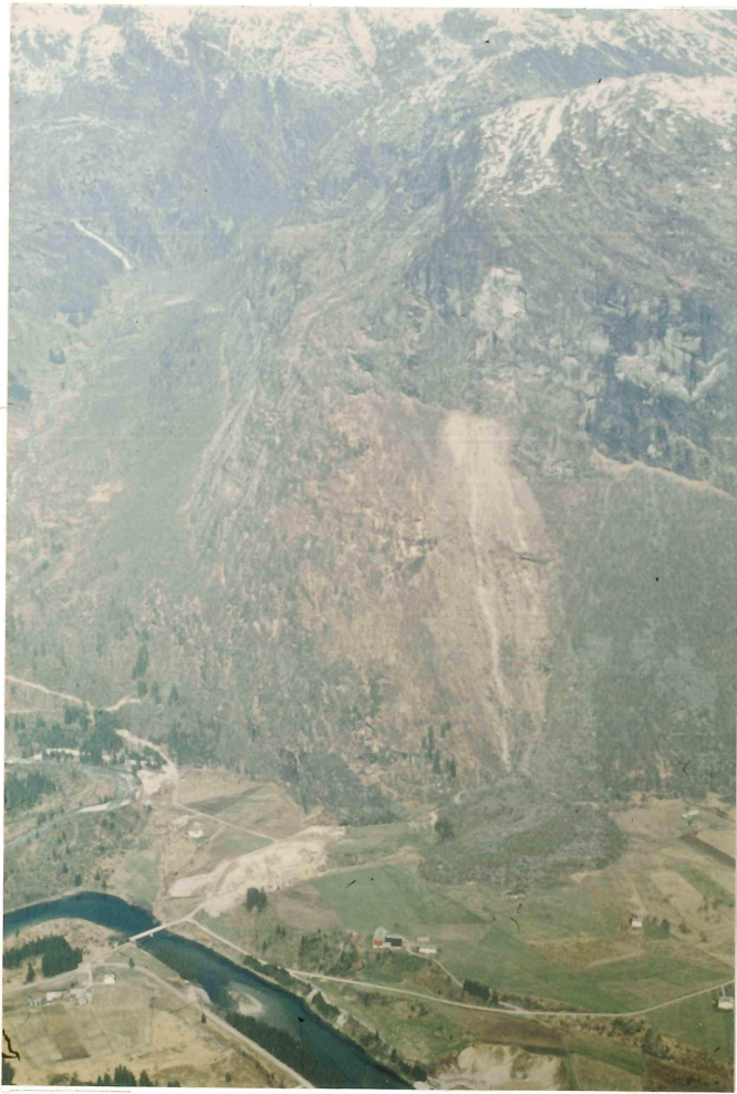
Fig. 83. Dagens utseende av raset ved nedre Helland.
