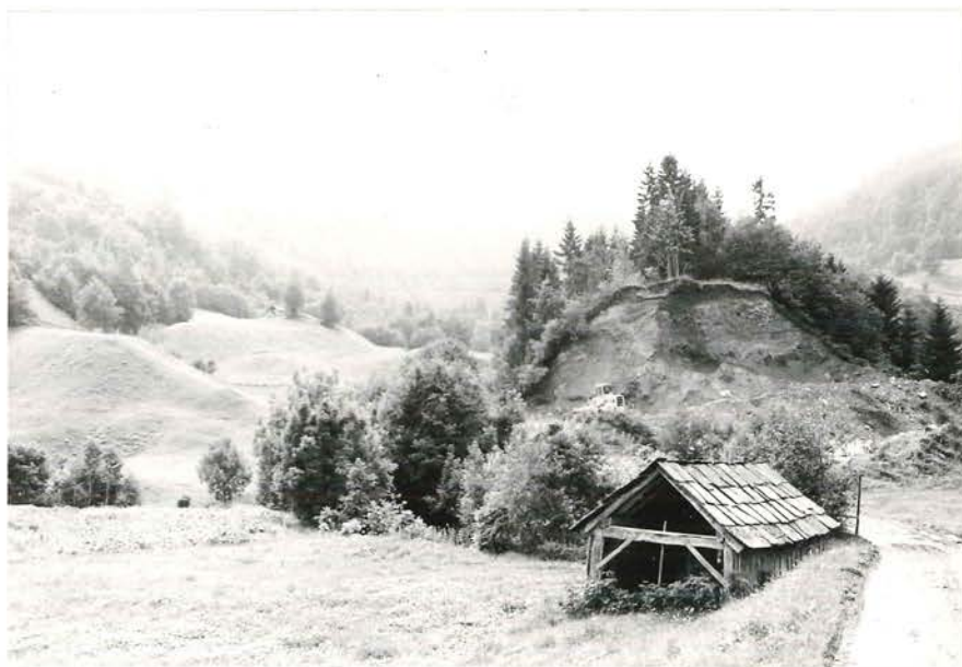
Fig. 58. Neteland massetak sett mot VSV.
