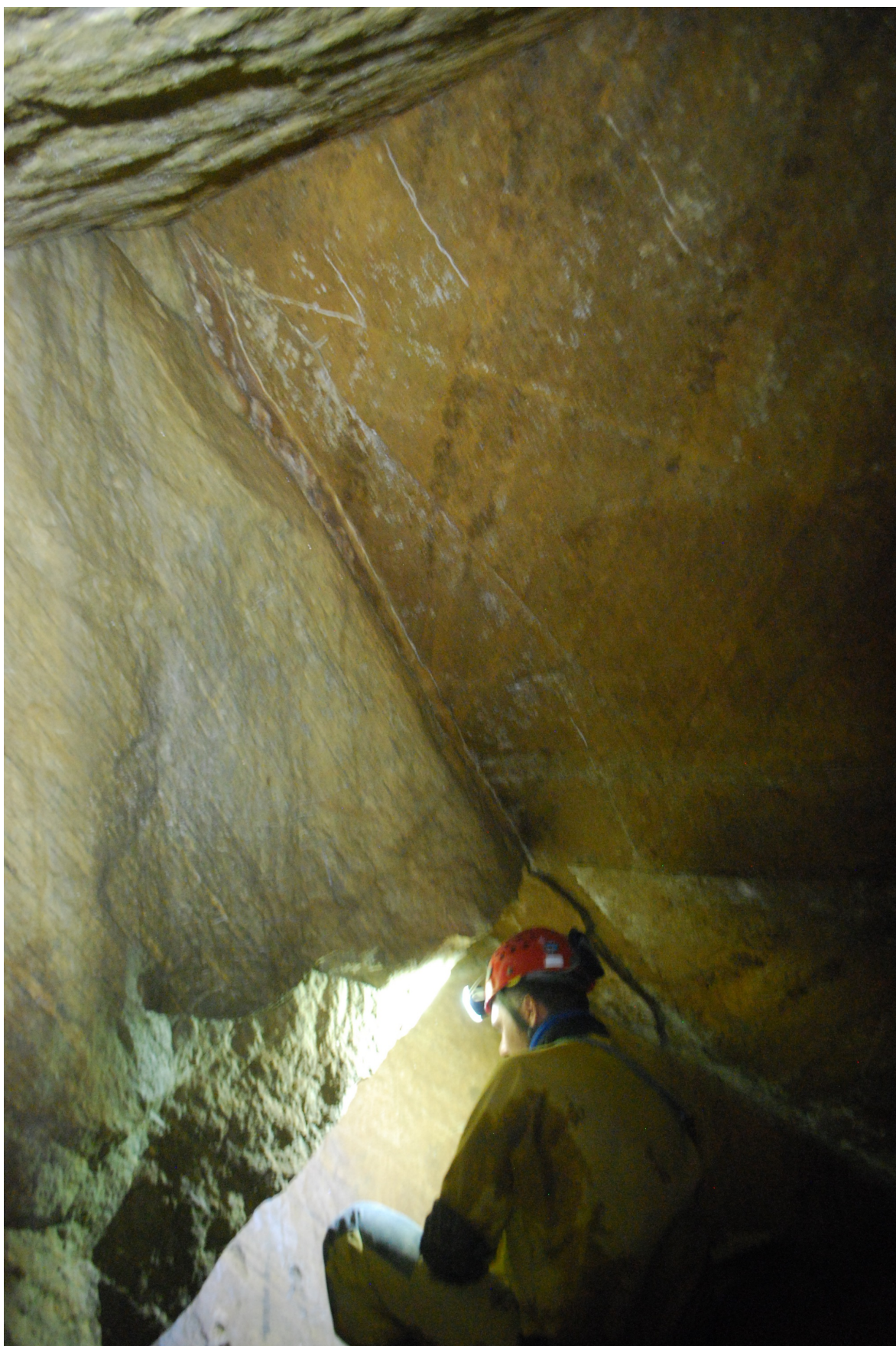
Figur 5.2.6: Bildet er tatt i ene hjørnet nederst i Kjelleren og viser hvor en blokk har sklidd ut. Lagdelingen som typisk er taket, er flaten til høyre i bildet.
