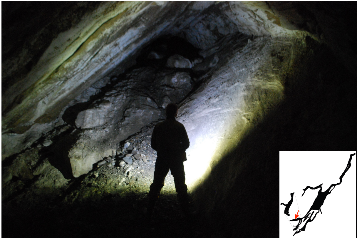
Figur 5.2.3: Bildet er tatt fra Heisen mot Proppen. Bildet viser tydelig lagdelingen i marmoren hvor blokker har glidd ut. Korridoren er blokkert i enden, av morenemateriale.
