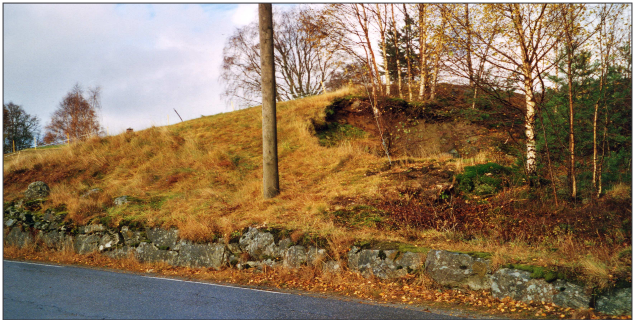
Figur 2.11 Randmoreneryggen (UTM 217 336) på Skarveland. Sett mot nordvest.
