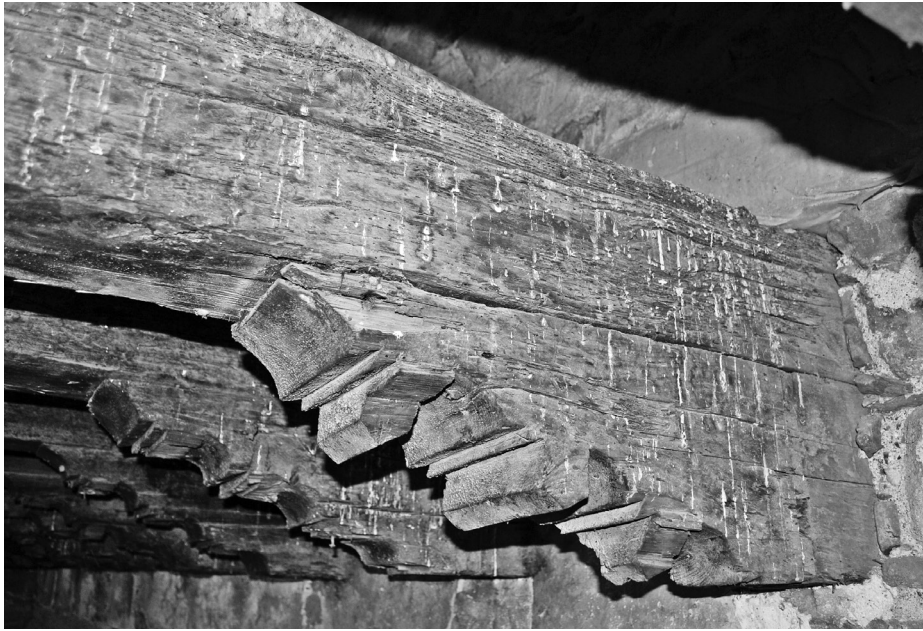
Εικόνα 13: Φουρούσι και δοκός της ανώτερης στάθμης (οροφής του ορόφου), όπου τα δύο ξύλινα στοιχεία είναι σε επαφή.
