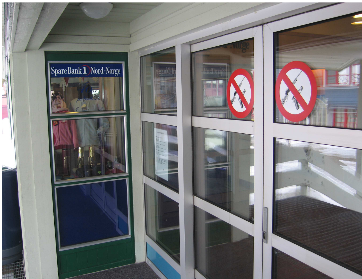
Figur 3 Inngangspartiet til bank og postbygg
