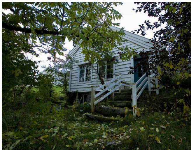
Fig. 84 Trappegelenderet slik det framleis står på nye Jølster prestegård. (Foto: Lene Sørøy Neverdal, 2009.)
