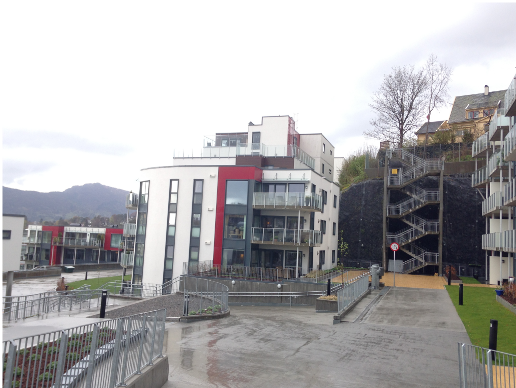
Ill. 2: Teigland eiendoms utbygging i Fondvegen. Merk fjellveggen og hvordan arealet er oppbygget.
