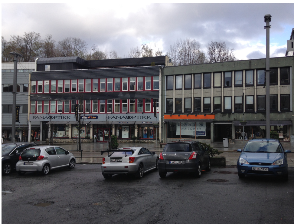
Ill. 3: Gågaten på Nesttun sett fra den planlagte hotelltomten. Tydelig 60-talls byggestil på fasadene peker tilbake til Nesttuns status som stasjonsby.
