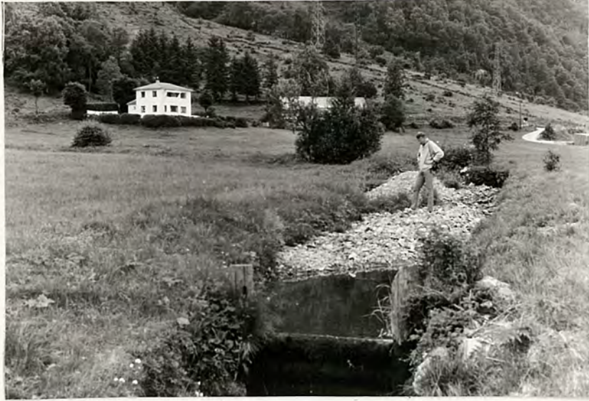
Fig. 109. Finare materiale distalt i vifta. I framgrunnen ein kunstig sedimentasjonsdam.
