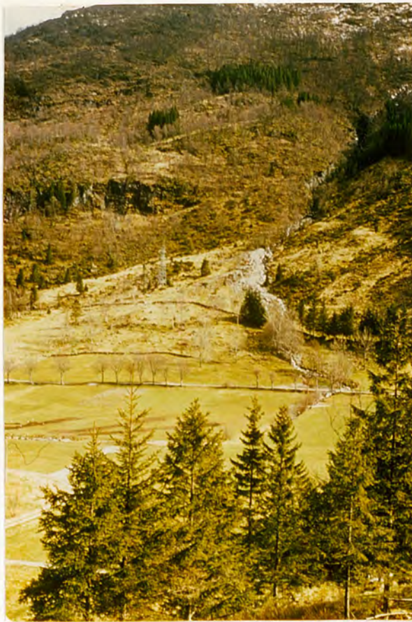
Fig. 105. Vifte II etter flaumskredet i febr. 1973.
