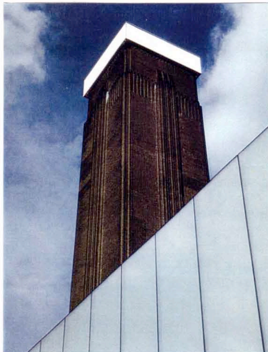
2. Tate Modern, detalj av pipa.
