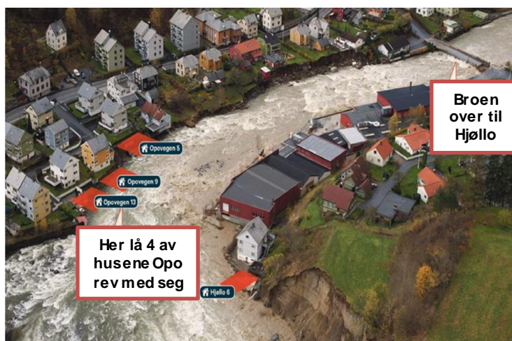
Figur 3 Hus som ble tatt av flommen i Odda 2014. (NVE, 2015g)
