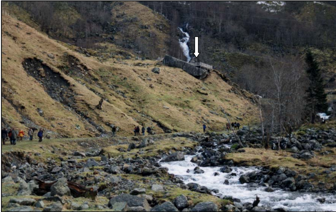
Figur 6.6.2 : Bruteigsteinen sett nedenfra
