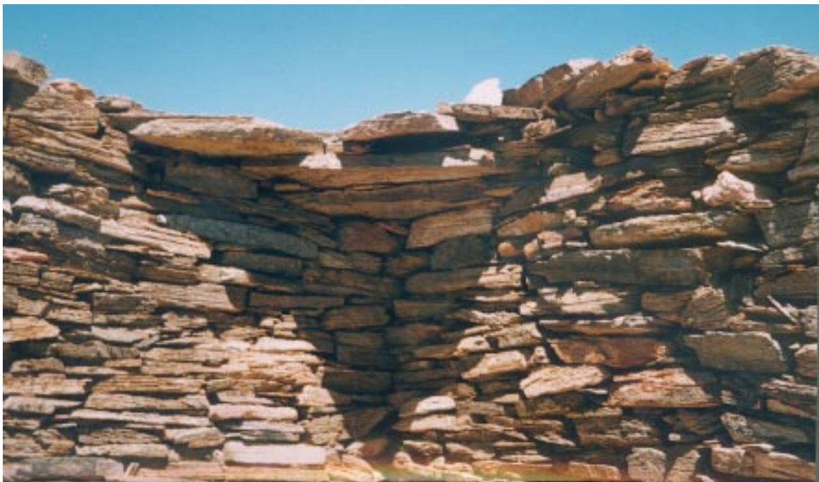
Figur 24. Deler av takkonstruksjonen på bygning i Wadi Nugrus.
