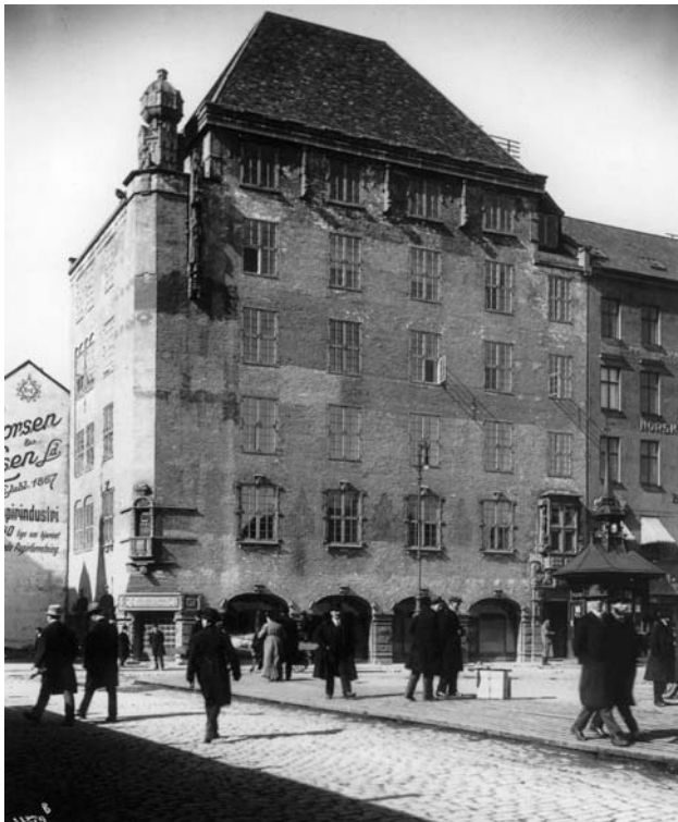
Magnus Poulsson: D.F.D.S.-bygningen, Karl Johansgt. 1
