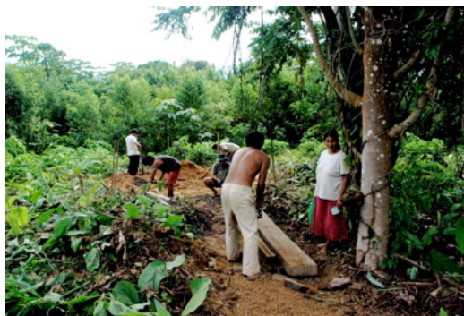
Arbeid med å bygge toalett. [FOTO: Eget]
