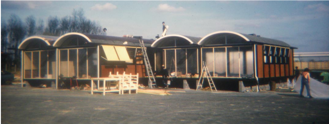
Fig. 106. Skolen i Orleans under bygging.
