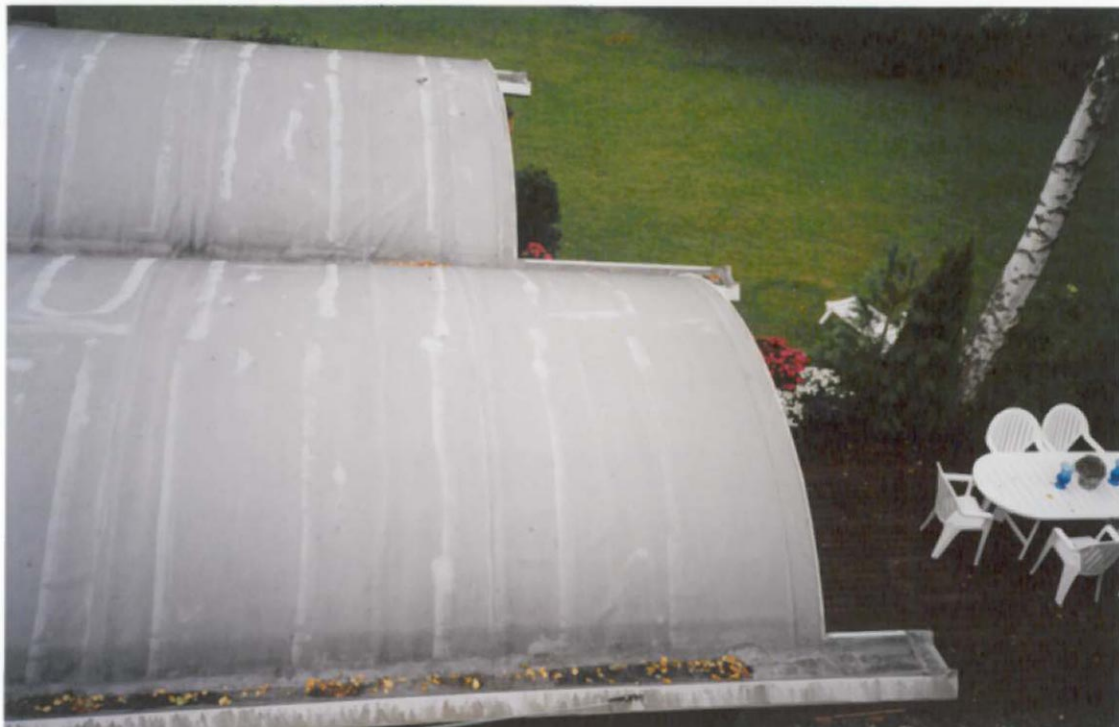
Fig 28. Sarnafilduk på taket av familien Willes sommerhus på Tjøme.
