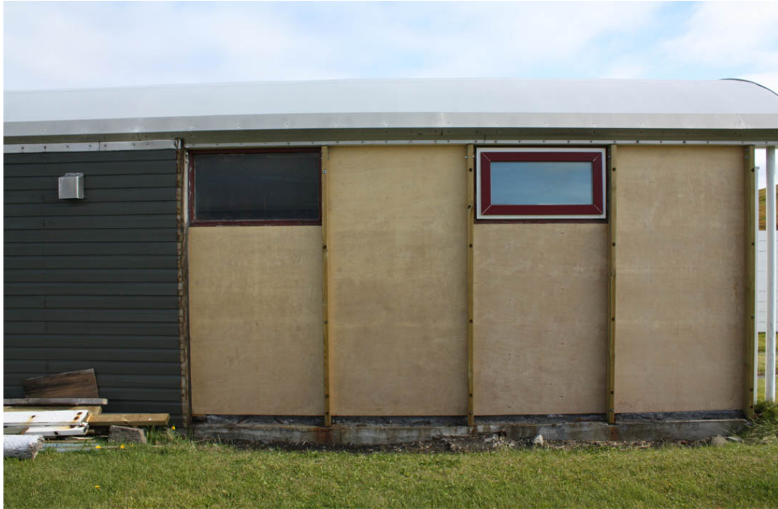
Fig.64. Fra Vestmannaeyjar, Island. Eldre Sun House -elementer byttes ut med selvlagde nye elementer. De brukte elementene ligger i en haug til venstre på bildet. Vinduet til høyre er også nytt, tilpasset systemets mål.
