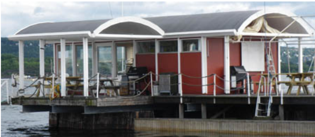
Fig. 85. Huset slik det fremstår i dag, i bruk som regattakontor. Taket på den åpne delen er blitt større. Legg merke til forskjellen på de to takbuene.
