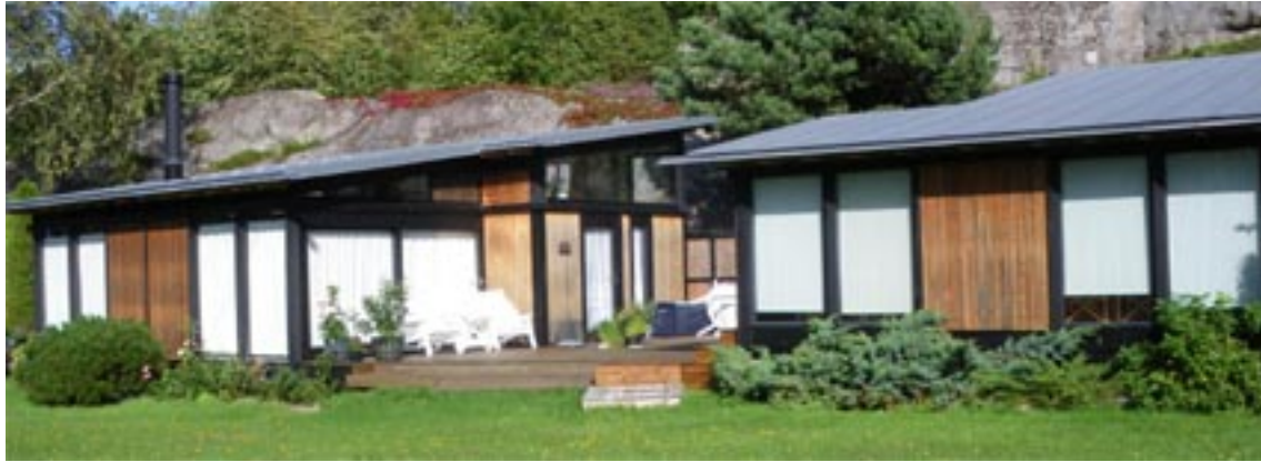
Fig. 87. Familien Willes sommerhus slik det ser ut etter ombygging. Taket er skiftet, nye vinduer er satt inn og veggelementene er dels restaurerte, dels nylagde, i lerk. Annekset er kommet til senere enn hytta, og er ikke et Sun House , men er bygget etter de samme mål for å gi stedet en bedre helhet.
