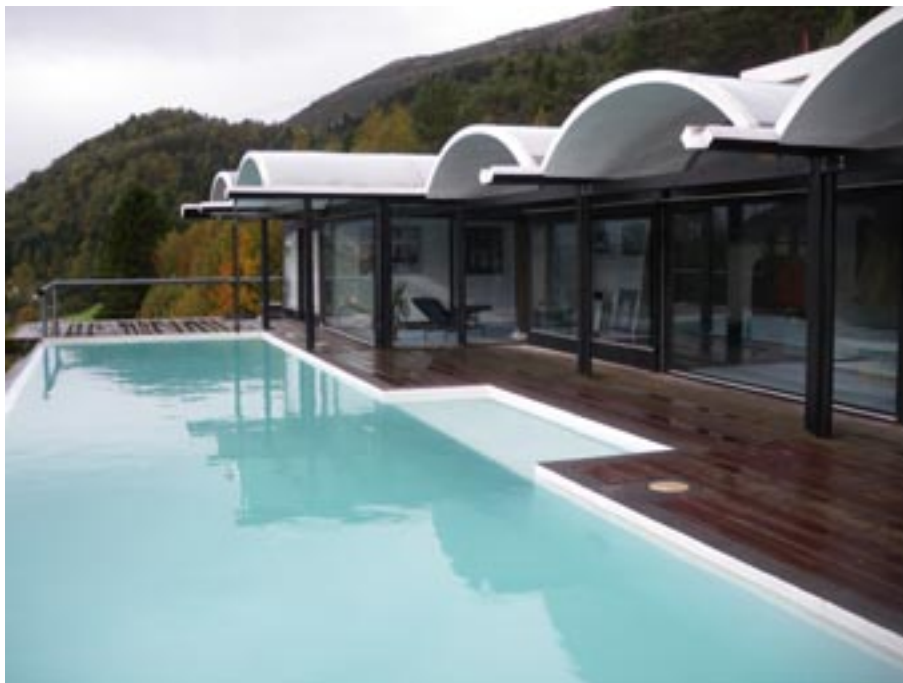
Fig. 24. Fra Villa Bache-Wiig i Eivindvik. De karakteristiske takbuene og de langsgående bjelkene som stikker ut forbi taket og som samtidig fungerer som takrenner.
