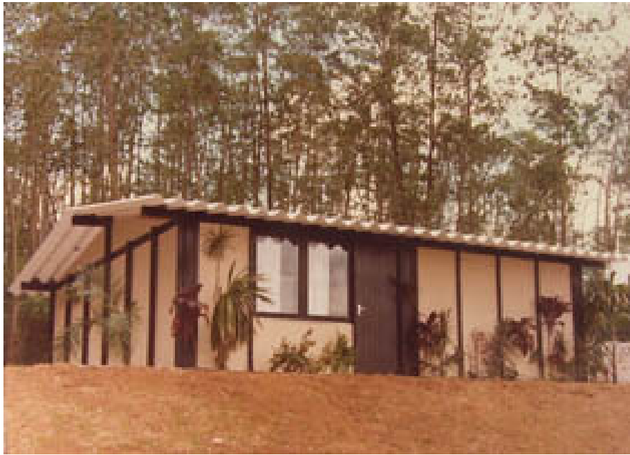
Fig. 57. Hus bygget i Brasil av Servlease. Reisverk, vegger, dører og vinduer er i Sun House – elementer, men det standardformede taket gjør at huset ikke har den fleksibiliteten som kjennetegner Sun House .
