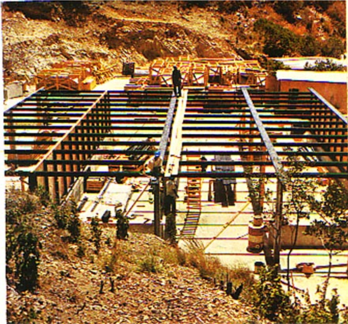
Fig.110. Fra Montering på Virgin Gorda, 1971. Muligens lagerbygningen med spesielt stor takhøyde.
