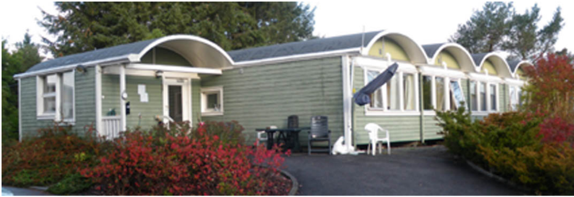
Fig.67. Fra Askøy ved Bergen. Sun House med innbygde stendere og avkappede takrenner.
