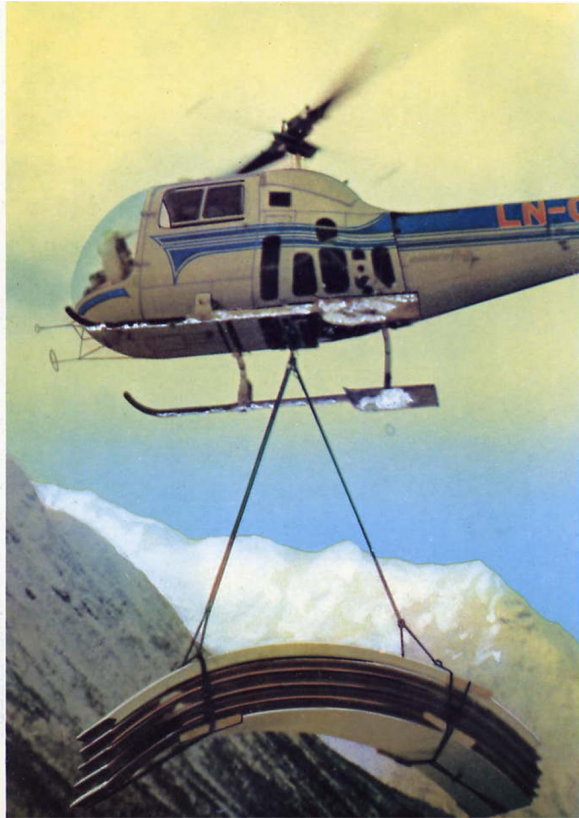
Fig. 23. Takelementer flys inn til en anleggsbrakke på Strynefjell.
