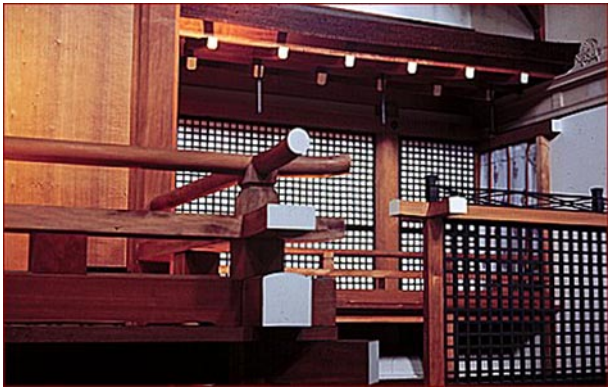
Fig. 43. Intrikat sammenføring av tak, fra bymuseet i Kyoto.
