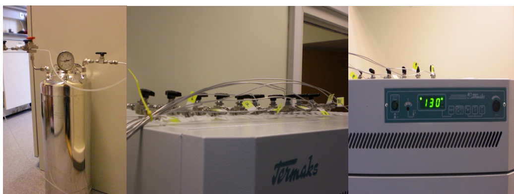
Figur 3.7.2: Venstre: Trykktank med destillert vann som gir trykkstøtte inn til cellene. Midten: System av ventiler som kan isolere trykket inn til hver enkelt celle. Høyre: Viser temperatur på ovnen under forsøkene.
