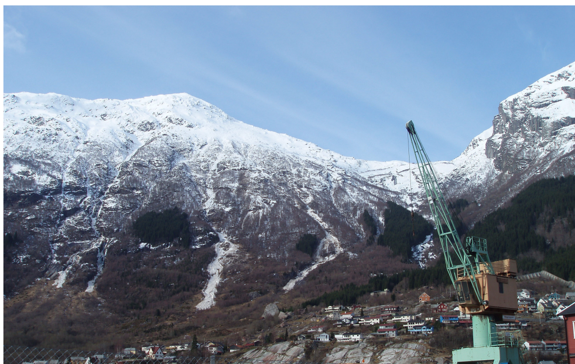
Bilde 18. Skred på Tokheim, 19.3.2010. Fra venstre: Breiskredet, Røynhammarskredet og Rindaskredet (foto: Gunnar Moland).
