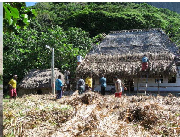
Bygging av ny bure ( were levu ) til høvdingen i Namara.
