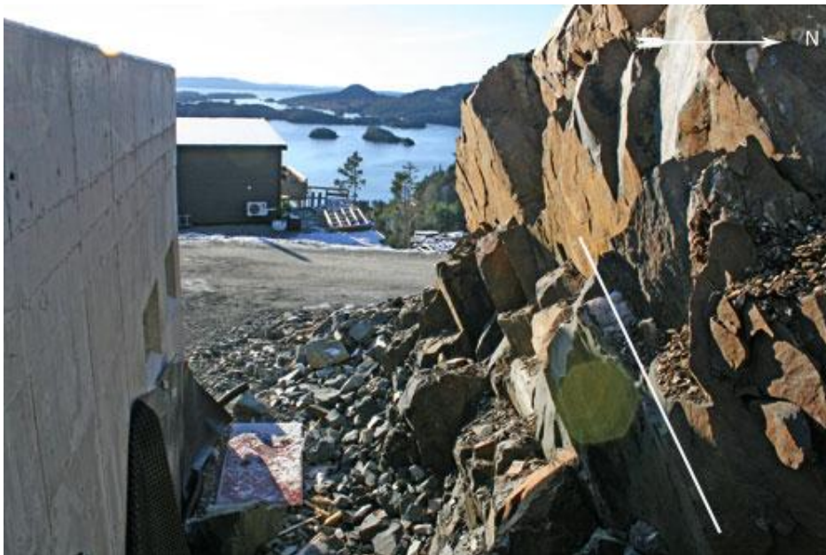
Figur 29. Hengande flater og søyler etter sprenging
