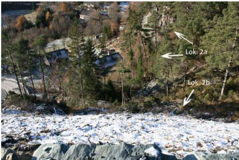
Figur 27. Bildet viser fyllmassen i lokalitet 2b sett ovanfrå. Jord og kvist er synleg under snøen. Lokalitet 2a ligg noko bortanfor, det naturlege dreneringsløpet til den naturlege skråninga passerar til venstre for dette huset.
