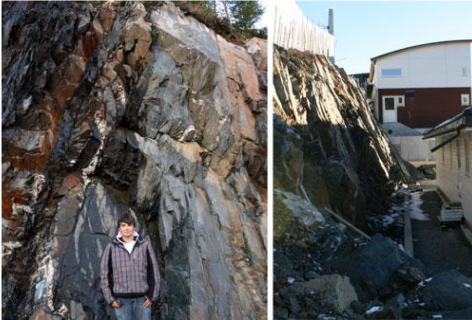
Figur 28. Venstre bilde viser overhengande blokker i ei skjering til vegen i byggefeltet. Høgre bilde viser eksempel på at skråningar og sprekkeretning i bakkant av fleire tomter er parallelle.
