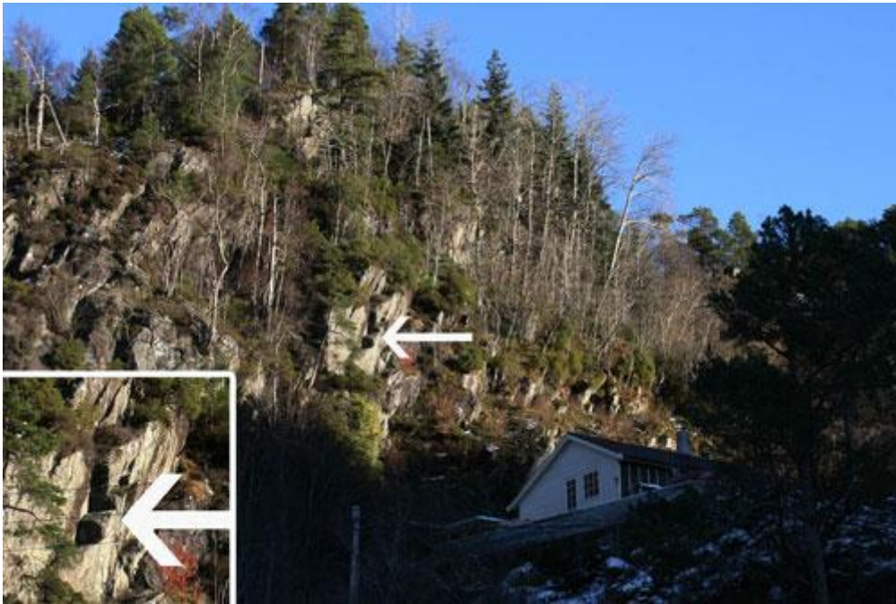
Figur 55. Lokaliteten 5d er ein bratt fjellskrent med ein einebustad tett inntil. Pila peikar på ei blokk som ser ut til å vere laus.
