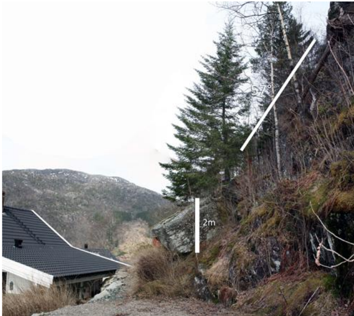
Figur 57. Lokalitet 5d. Huset er bygd like under to store blokkar som ligg i ei skråning. I fjellskrenten bak er det blokker med opne sprekker bak.
